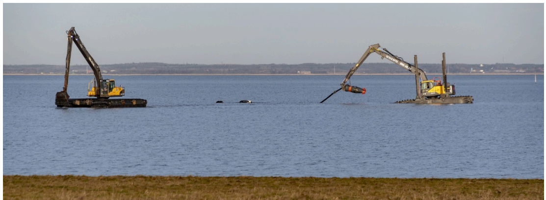
Figur 12: Uddybning af sejlrenden til Sønderho i vinteren 2018/19. Maskinen til højre styrer en cuttersuger, der pumper sand og vand gennem et 400 m langt fleksibelt rør. Maskinen til venstre styrer udpumpningen af sand lang Fanøs østkyst. (Foto Per Hofman Hansen, primo januar 2019).
