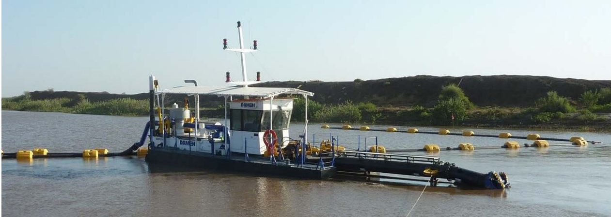
Figur 2-9: Cuttersuger monteret på flåde med pumpestation og jordspyd for fastholdelse under arbejdet
